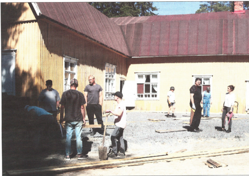
Kirkonkylän Nuorisoseuran talon Sampolan taakse rakentuu kesäteatterinäyttämö ja katsomo pitkälti talkootyönä. Talkoolaiset suunnittelemassa päivän töitä heinäkuun ensimmäisissä talkoissa. Ennen betonin valua näyttämön tiivistetty pohja on vielä tasattava oikeaan korkoon sekä asennettava routaeristys.
