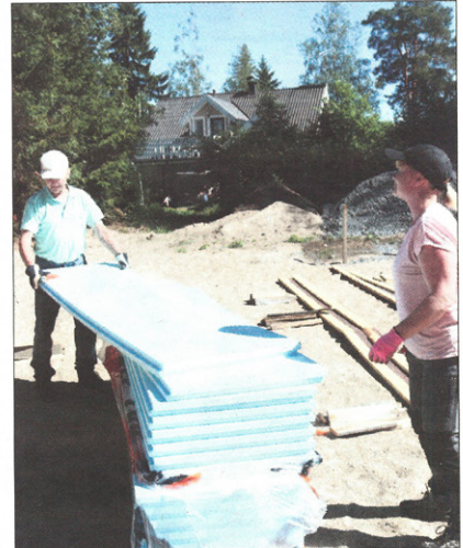
Kalevi Ojala ja Minna Savela purkivat eristelevyjä heinäkuun ensimmäisissä talkoissa toissa torstaina.
